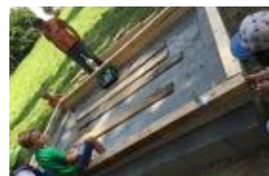
Ein gutes Fundament ist wichtig
