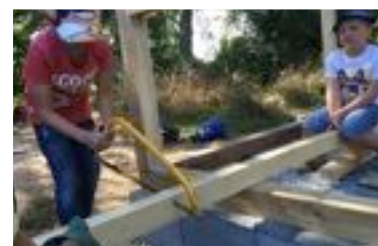
Mit der Säge die Balken zurechtschneiden
